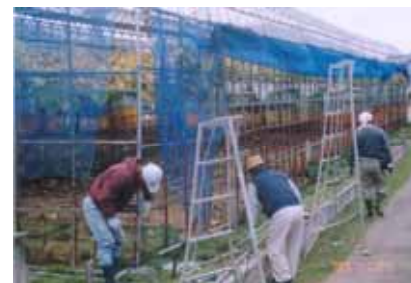
(フィルム張替え作業中)
